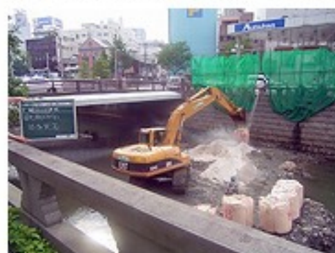
再生石膏中性固化材使用した施工事例
