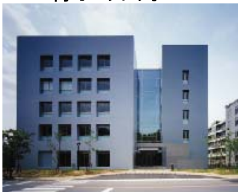
共同研究棟 延べ面積 2,017m 2 内 オープンラボ 717m 2
