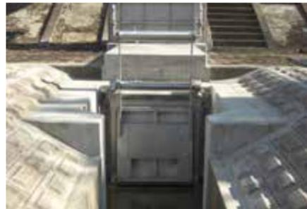
オートゲートステップレス バタフライフロートは、動力を使わずに稼働が可能な自動水路開閉ゲートだ。従来、同様の樋門では無動力化する際に、設置箇所の底面に段差を設けることが不可欠だったが、ゲートに可動式の水密ゴムを採用して段差が不要となった。これにより、工費の削減と工期の大幅短縮を実現。さらに水流の増水によって自動的に開閉するため、作業担当者のいち早い避難も可能になった。
