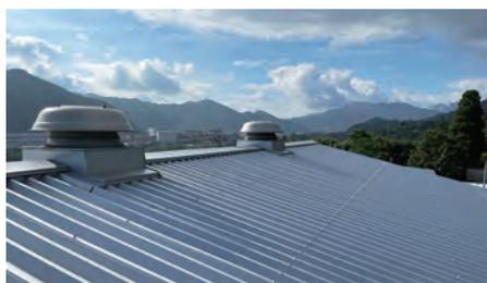
「遮熱鋼板ラップ工法」は、工場屋根に遮熱材を用いた特殊な工法で冷暖房機器に頼らない高断熱空間をつくり上げる。施工前と比べて冷暖房費を60%削減することが見込める。遮熱技術を屋根材に応用することで省エネルギー効果を高めた。
