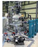
ウナギの養殖を省エネ、省人化、高効率で行う閉鎖型陸上養殖システムと遠隔管理システムを実用化した。従来の生けす方式に比べて5倍以上の高密度育成を実現した。
