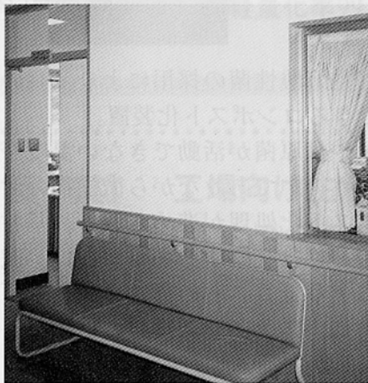
ホタテ貝殻を原料としたシックハウス対応の内装材。ホタテ貝殻を微粉碎し、高温焼成することによってホルムアルデヒドや揮発性有機化合物の吸着性に優れた材料とした。
