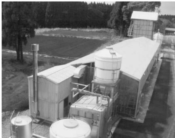
従来の生ゴミの加熱乾燥方式における熱利用効率が30%なのに対して、麹菌の発酵熱で乾燥するため、1,500円/t程度の低コストで水分を20%以下に乾燥し、熱利用効率80%の低コスト乾燥方式を確立した。
