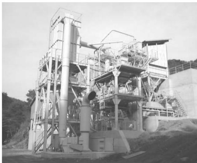
碎石場で発生する余剰材を利用して生コンなどで必要とする細骨材を安定して生産する製砂プラント。
